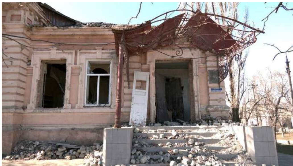
Il. 4. Budynek Rejonowego Muzeum Krajoznawczego w Orchiwie, uszkodzony w wyniku ostrzału rosyjskich wojsk. Fot.: Суспільне. Запоріжжя, 02.03.2024; https://suspilne.media/696968-zranenij-poskodzenij-ale-poki-so-stoit-akij-mae-viglad-kraeznavcij-muzej-u-prifrontovomu-orihovi-na-zaporizzi/ ; data odczytu: 15.03.2024.
