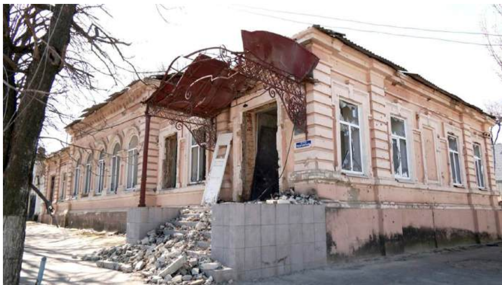
Il. 3. Budynek Rejonowego Muzeum Krajoznawczego w Orchiwie, uszkodzony w wyniku ostrzału rosyjskich wojsk. Fot.: Суспільне. Запоріжжя, 02.03.2024; https://suspilne.media/696968-zranenij-poskodzenij-ale-poki-so-stoit-akij-mae-viglad-kraeznavcij-muzej-u-prifrontovomu-orihovi-na-zaporizzi/ ; data odczytu: 15.03.2024.
