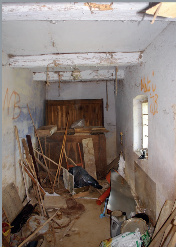
Il. 23. Wnętrze komory, fot. T. Łopatkiewicz, maj 2020
