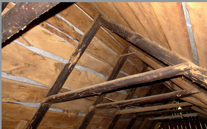
Il. 30. Para starych krokwi pochodzących z pierwotnego dachu czterospadowego i dwa gniazda powyżej jętki, w których osadzona była belka stabilizująca w pionie komin sztagowy, fot. T. Łopatkiewicz, maj 2020
