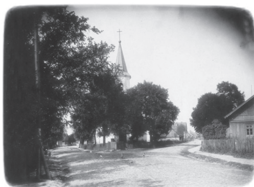
Ilustracja 2. Szkoła luterańska – drewniany budynek po prawej stronie
