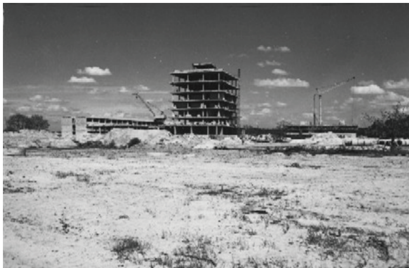
Fot. 4. Budowa Rektoratu (wysoki budynek), bliżej budowana siedziba Instytutu Chemii UMK
