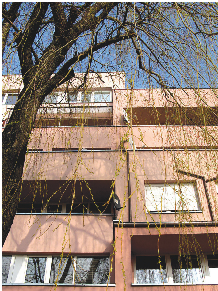
9. Fragment budynku na osiedlu Kuźniki po termomodernizacji; fot. A. Gabiś
