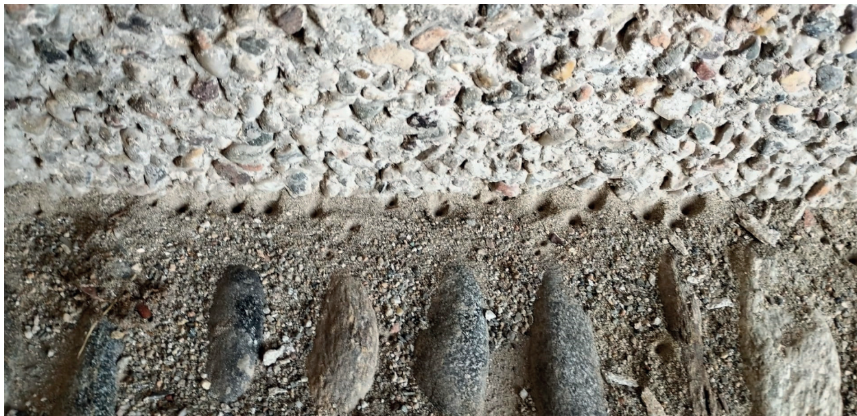
Ryc. 3. Pułapki piaskolwów zbudowane wzdłuż ściany budynku miejskiego, Verbania, Włochy. Zdjęcie: D. Stec
