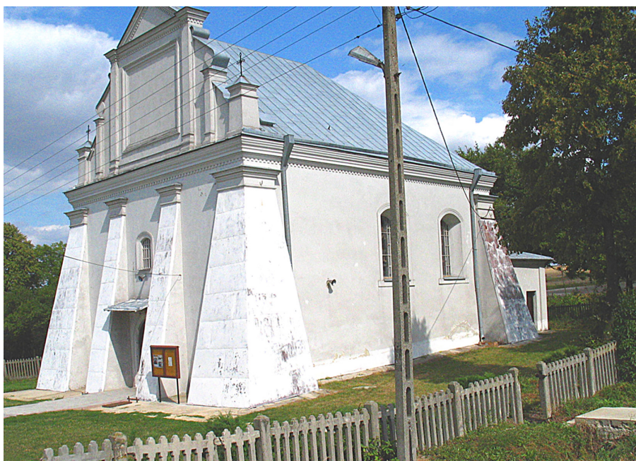
Ryc. 3. Kościół parafialny w Spasie-Podgórzu k. Chełma. W jego części prezbiterialnej i części nawy głównej zidentyfikowano budowlę sakralną datowaną na wiek XIII. Widok od płd.-zach. Fot. A. Buko.
