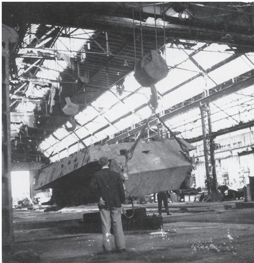
Fot. 4. Stocznia Schichaua w Gdańsku, 1945 r. Jedna z hal, w której wyposażane były sekcje U-Bootów typu XXI. Zdjęcie ze zbiorów Archiwum Państwowego w Gdańsku
