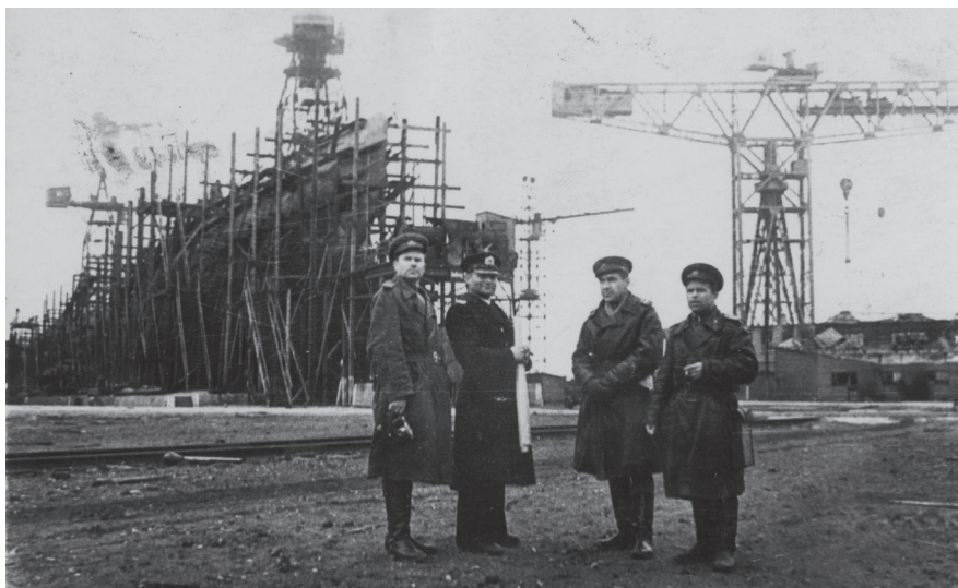
Fot. 8. Stocznia Schichaua w Gdańsku, wiosna 1945 r. Nieukończony U-Boot typu XXI stojący na stoczniowej pochylni. Na pierwszym planie radzieccy oficerowie. Zdjęcie ze zbiorów Archiwum Państwowego w Gdańsku
