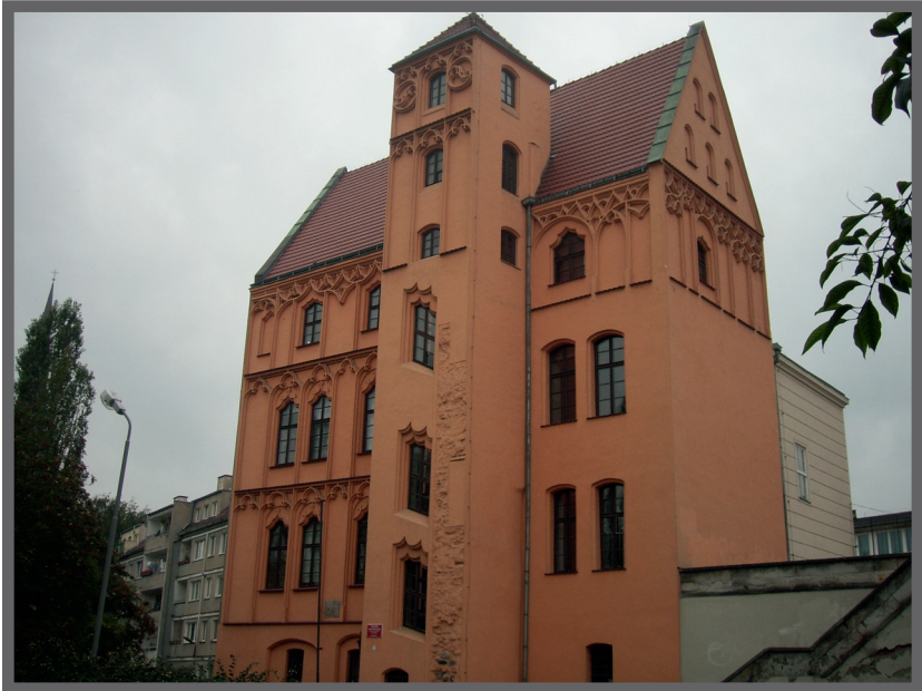
Abb. 4. Das Loitzenhaus nach dem Wiederaufbau. Ansicht 2011 (Fot. Małgorzata Gwiazdowska)
