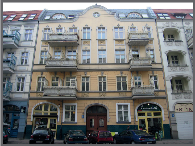
Abb. 10. Fragment des Stadtzentrums nach der Sanierung, die Poststraße. Ansicht 2011 (Fot. Małgorzata Gwiazdowska)
