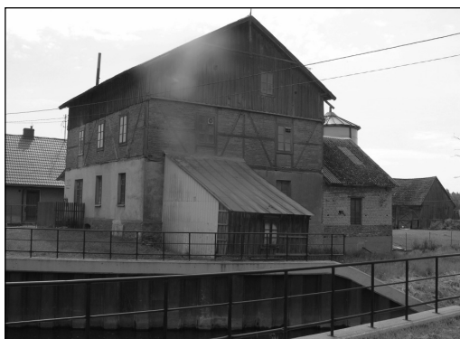
Fot. 2. Młyn w Rudce-Skrodzie, widok od północnego zachodu (fot. M. Skrzos)
