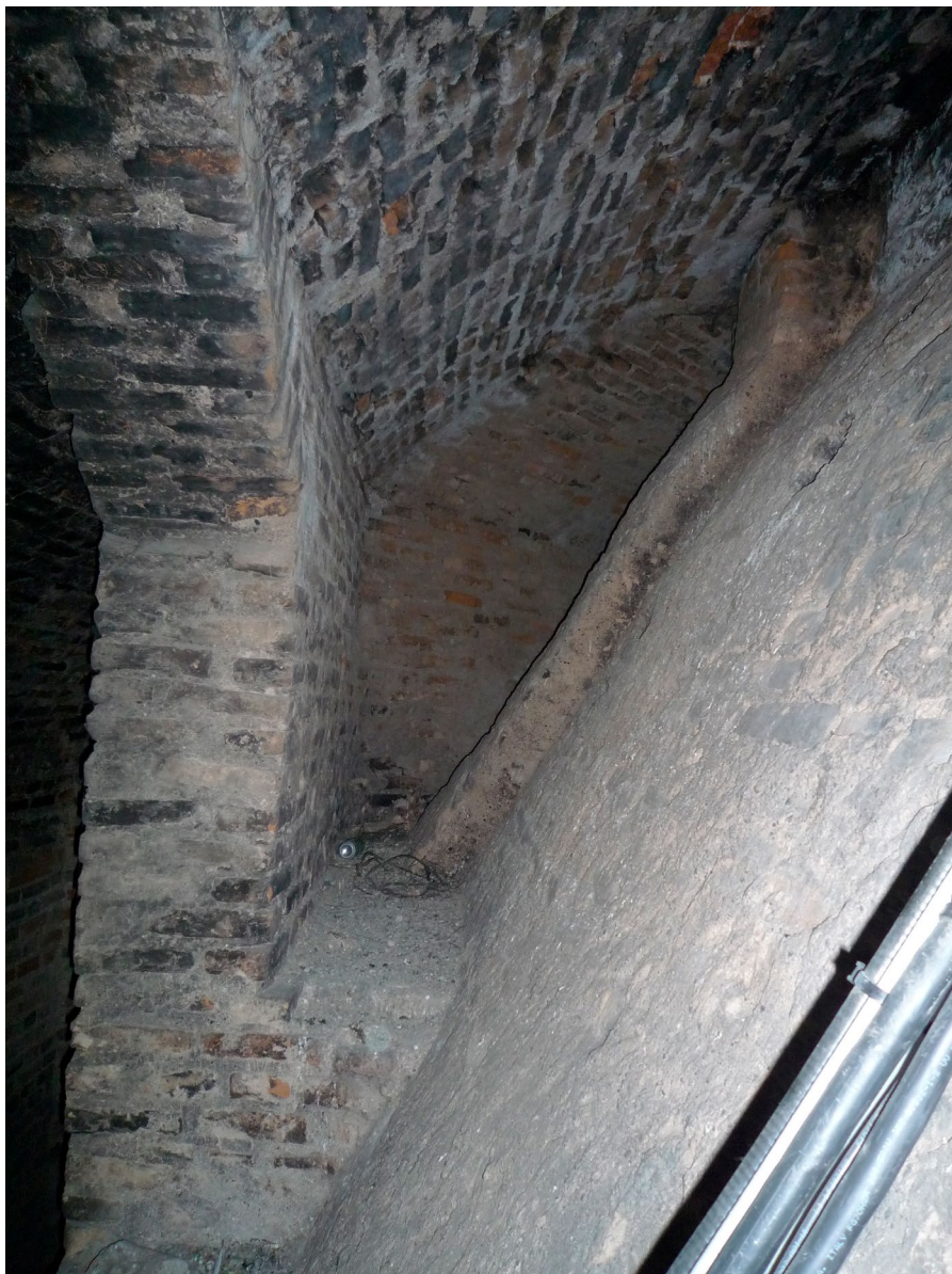
Il. 8. Wilno, kościół trynitarSKI. Przestrzeń poddasza nawy od strony fasady, 2018.
