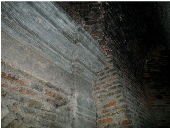
Il. 12. Wilno, kościół trynitarcki. Tylne elewacja drugiej kondygnacji wieży zachodniej, od strony poddasza sklepienia nawy, fragment, 2018. Fot. K. Guttmejer Widoczny prawidłowo i precyzyjnie wyciągnięty profil gzymsu, z klasycznym podcięciem płyty gzymsu, nadto dobudowany wtórnie mur „tamburu”
