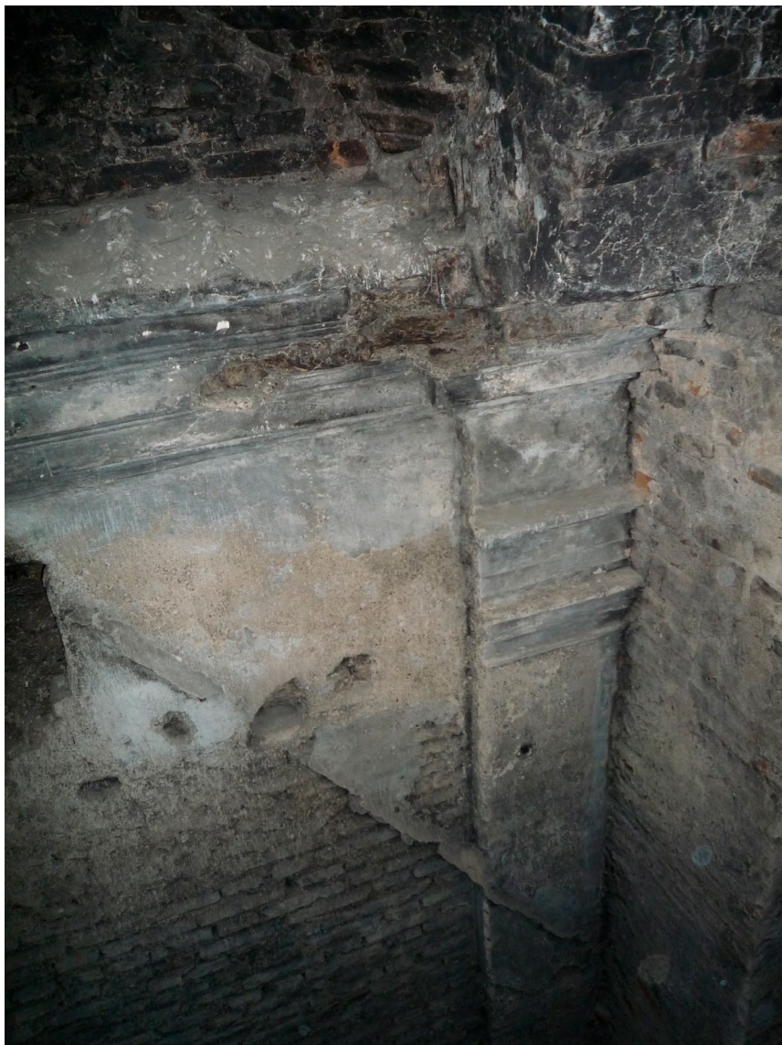
Il. 14. Wilno, kościół trynitański. Tylne elewacja drugiej kondygnacji wieży wschodniej, od strony poddasza sklepienia nawy, fragment, 2018. Fot. K. Guttmejer Widoczna tynkowana partia ściany z pilastrem i ślad po dwuspadowym daszku. Obok wtórnie dostawiony mur – wewnętrzna „szkarpa” tylnej ściany fasady, a na gzymsie oparty fragment muru wspierającego dach
