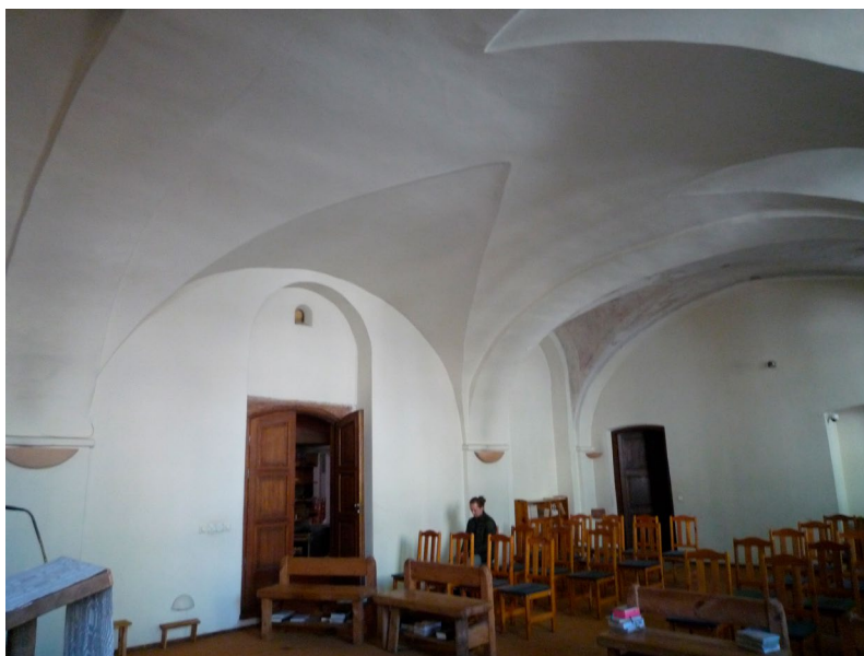
Il. 4. Wilno, kościół trynitarSKI. Zakrystia, widok na wejście do kościoła, w sklepieniu szeroka luneta, 2018. Fot. K. Guttmejer
