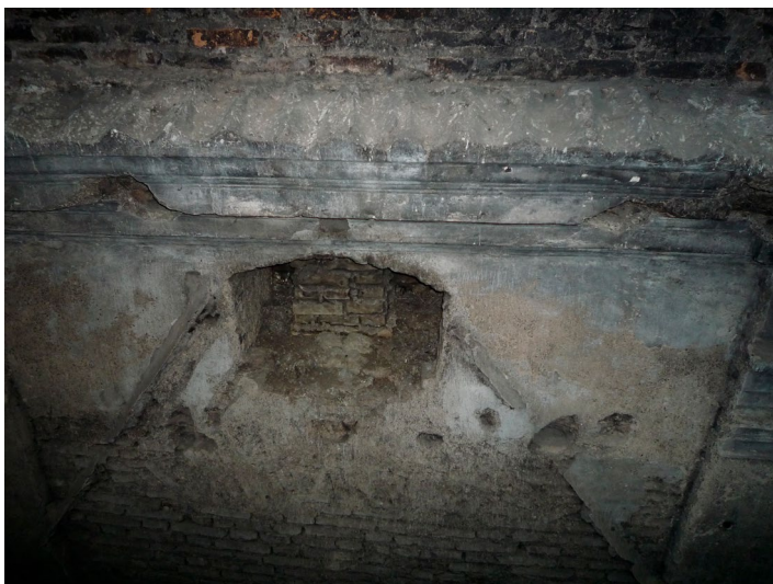
Il. 13. Wilno, kościół trynitarcki. Tylne elewacja drugiej kondygnacji wieży wschodniej, od strony poddasza sklepienia nawy, 2018. Fot. K. Guttmejer Widoczna tynkowana partia elewacji, z boków fragmenty pilastrów. Nadto ślad po dwuspadowym daszku, pod którym ściana bez tynku. Ciemne okopcenie to ślad po pożarze dachu w latach 70. XX w.
