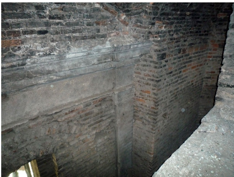
Il. 11. Wilno, kościół trynitański. Tylna elewacja drugiej kondygnacji wieży zachodniej, od strony poddasza sklepienia nawy, 2018. Fot. K. Guttmejer Widoczny tynkowany pilaster wraz belkowaniem. Do tej partii wieży dobudowany wtórnie nieotynkowany mur „tamburu”. Ciemne okopcenie to ślad po pożarze dachu w latach 70. XX w.
