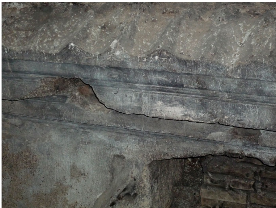
Il. 15. Wilno, kościół trynitański. Tylna elewacja drugiej kondygnacji wieży wschodniej, od strony poddasza sklepienia nawy, fragment, 2018. Fot. K. Guttmejer Widoczny odcinek gzymsu z wyraźnym śladem po leżących pierwotnie dachówkach esówkach
