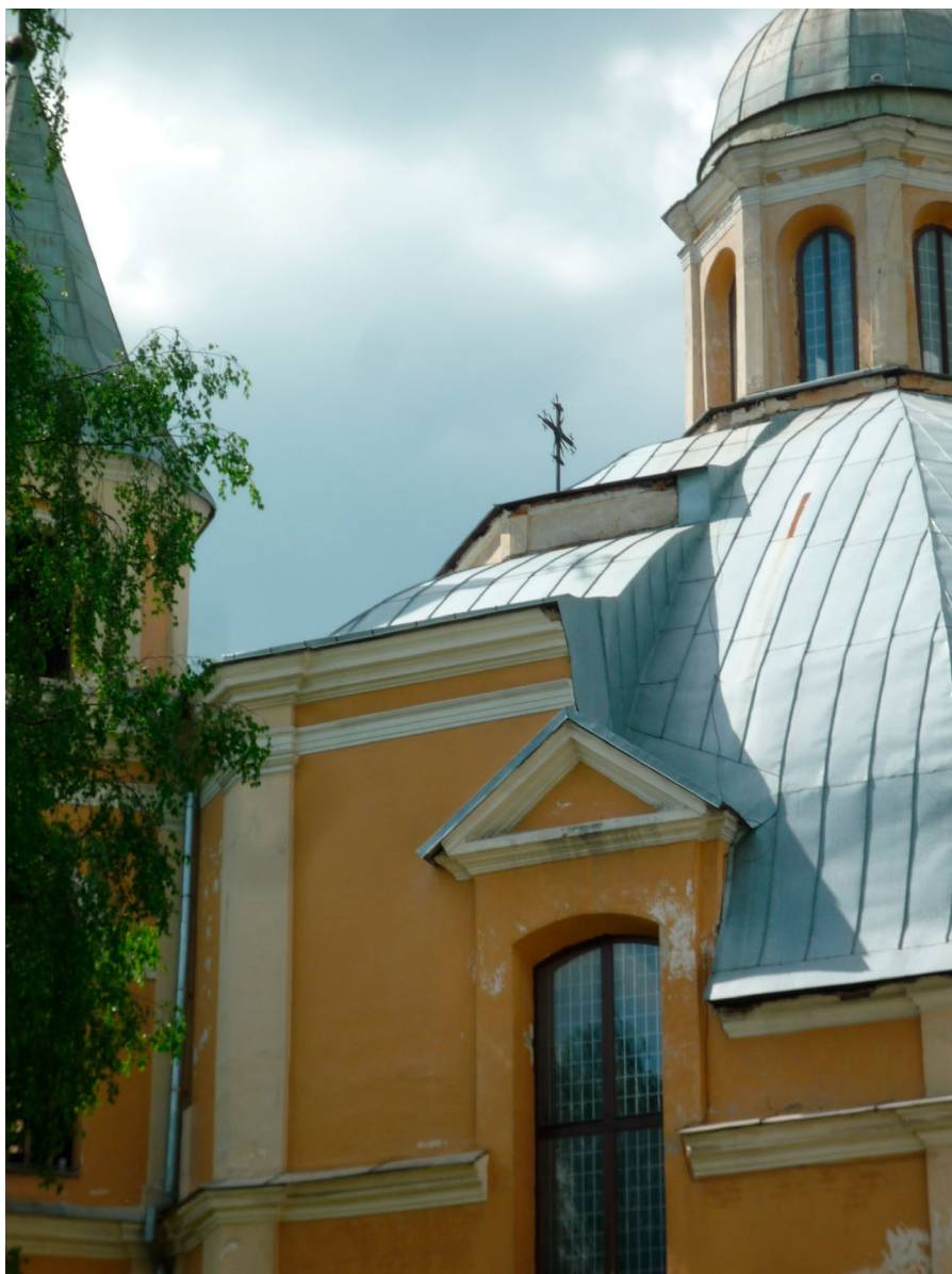
Il. 16. Wilno, kościół trynitarcki. Widok na dach kościoła od wschodu, 2018. Fot. K. Guttmejer Północna część (z prawej) spływa na niską attykę kryjącą podstawę sklepienia; południowa część, w stronę wieży, ma znacznie wyżej podniesiony – wtórnie – mur o formie „tamburu”, sięgający poziomu szczytu fasady
