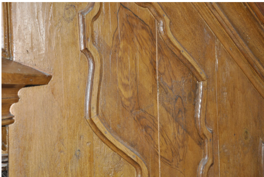
Fot. 8. Kościół w Ratajkach, fragment balustrady ambony, mazerunek imitujący drewno orzechowe, stan obecny. Fot. M. Fausek
