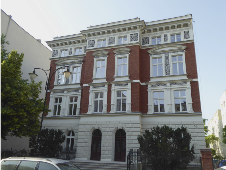
1. Willa miejska przy ul. Mickiewicza 81 w Toruniu, widok ogólny elewacji północnej. Fot. J. Kucharzewska, 2018
