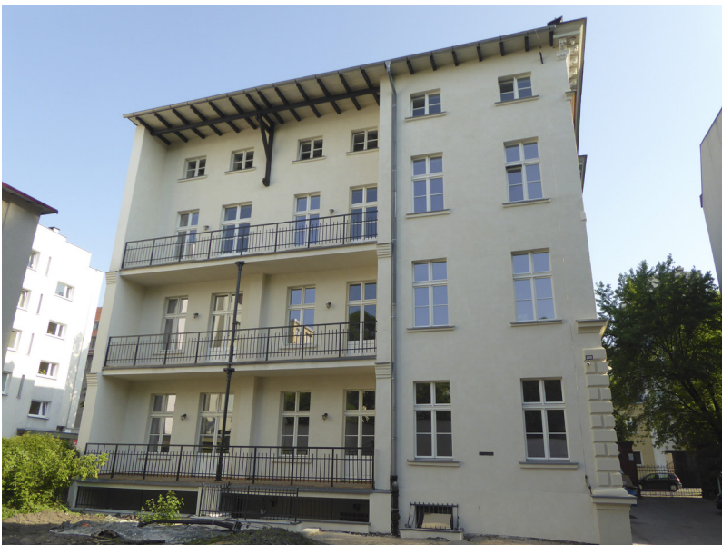
2. Willa miejska przy ul. Mickiewicza 81 w Toruniu, widok ogólny od strony południowo- -wschodniej. Fot. J. Kucharzewska, 2018
