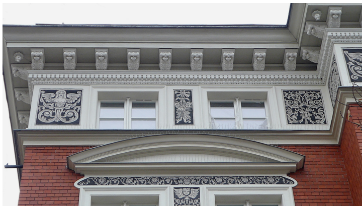
11. Fragment elewacji północnej – detal architektoniczny i dekoracja sgraffito. Fot. J. Kucharzewska, 2018
