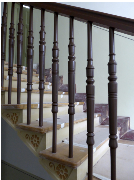
10. Fragment klatki schodowej z dekoracyjnym policzkiem zewnętrznym i podniebieniem, stan w trakcie remontu – oczyszczanie z wtórnych powłok malarskich. Fot. J. Kucharzewska, 2018
