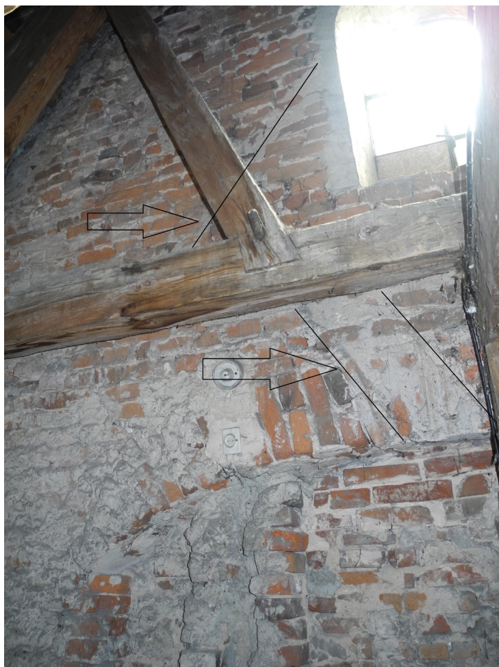
8. Kościół w zespole klasztornym Karczówka (Kielce). Wiązar wschodni od strony wschodniej. Widoczne ślady zastrzałów pierwotnej więźby dachowej (fot. M. Prarat, 2017).
