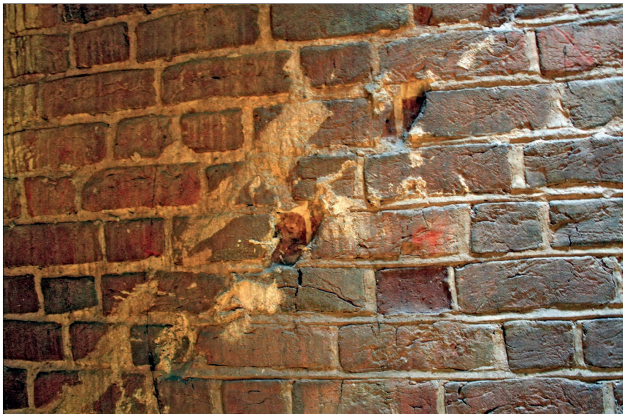
8. Późnoromański kościół w Tulcach. Szczyt zachodni (faza I, etap 4) części wschodniej nawy od strony zewnętrznej. Widoczne opracowanie spoiny jedynie pod krawędzią linii wcześniejszej połąci dachowej (świadczące o jej pierwotnym zarysie, zaplanowanym już podczas wznoszenia muru). Fot. Maciej Prarat, Karolina Zimna-Kawecka, 2014
