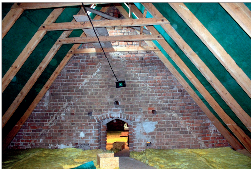
7. Późnoromański kościół w Tulcach. Szczyt zachodni (faza I, etap 4) części wschodniej nawy od strony zewnętrznej. Widoczne pierwotne przejście do trzeciego członu pierwotnej formy kościoła z zachowanym trójkątem połaci dachowych (wysokość odpowiadająca prezbiterium). Fot. Maciej Prarat, Karolina Zimna-Kawecka, 2014
