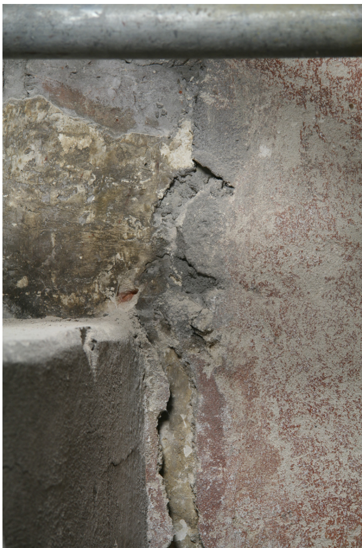
8. Dziergoń, kościół pw. Trójcy Przenajświętszej. Fragment wcześniejszego tynku, sprzed 1730 r., z zielonkawym opracowaniem malarskim, zachowany po prawej stronie mensy ołtarza północnego – za nim i w miejscu ubytku warstw osiemnastowiecznych. Fot. K. Szczepińska
