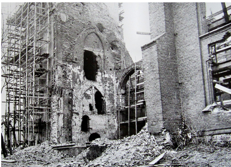
Il. 7. Wolin, kościół pw. św. Mikołaja. Widok wschodniej ściany wieży oraz częściowo rozebranej ściany południowej, około 1972. (Za: K. Kalita, fot. G. Solecki, „Kościół św. Mikołaja w Wolinie”, fot. 19.
