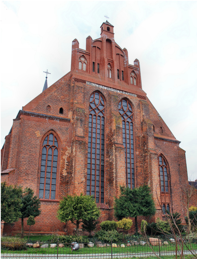
Il. 12. Wolin, kościół pw. św. Mikołaja. Zrekonstruowana ściana wschodnia, 2014. Fot. J. Gierlasiński
