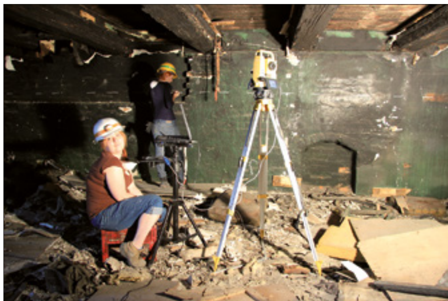
1. Zespół kamienic na ul. Mostowej 6. Inwentaryzacja pomiarowo-rysunkowa z wykorzystaniem tachimetra. Zakładanie punktów kontrolnych (fot. M. Prarat, 2014 r.)
