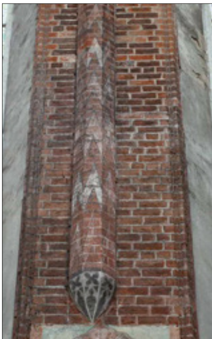
Fot. 12. Dekoracja malarska słuźki sklepiennej w chórze kościoła św. Jakuba w Toruniu, fot. ze zbiorów Autorki
