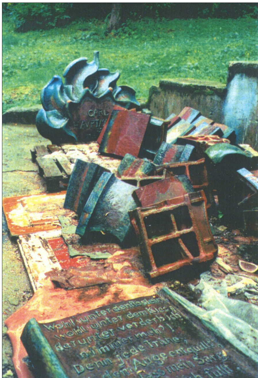
Fot. 2. Jak wyżej stan po dewastacji. Fot. zbiory PP PKZ – pracownia konserwacji kamienia
