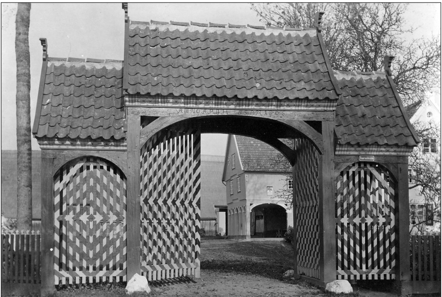
Il. 5. Jasionna, bram wjazdowa z 1806 r. do gospodarstwa po przeprowadzonych pracach konserwatorskich ( Die Denkmalpflege in der Provinz Westpreußen in den Jahren 1920 bis 1931. 17 Bericht an den Ausschuss zur Erforschung und zum Schutze der Denkmäler in der Provinz Ostpreußen erstattet von Bernhard Schmid Provinzialkonservator für den Regierungsbezirk Westpreußen, Königsberg 1932, S. 25, Abb. 7 )
