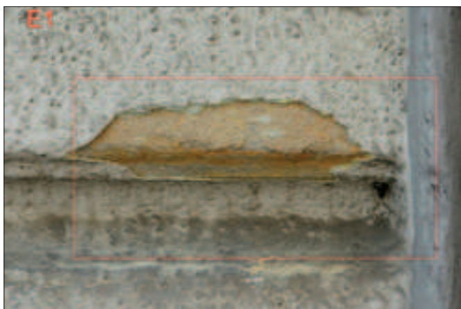
Il. 9. Widok odkrywki E1 na elewacji zabytkowego budynku przy ul. Żeromskiego 9 w Mrągowie. Widoczne oryginalne tynki barwione w masie na kolor pomarańczowy – wg NCS-u S 2040-Y20R (fot. E. Doleżyńska-Sewerniak)
