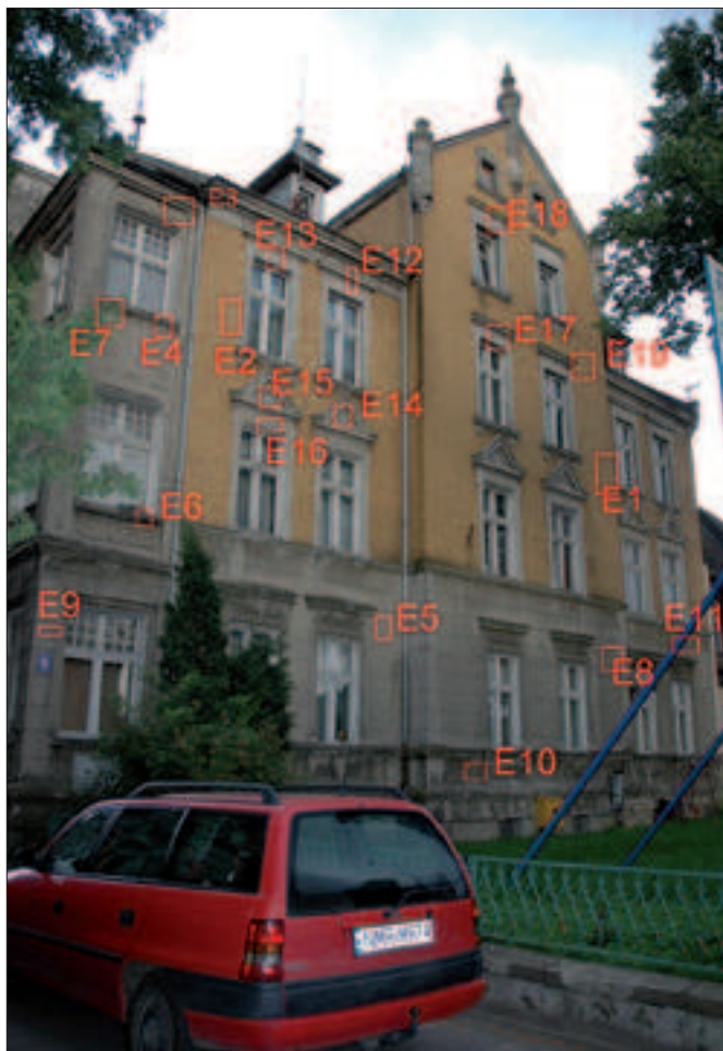
Il. 11. Widok elewacji frontowej zabytkowego budynku przy ul. Warszawskiej 53 w Mrągowie z zaznaczeniem miejsc wykonania badań (fot. E. Doleżyńska-Sewerniak)
