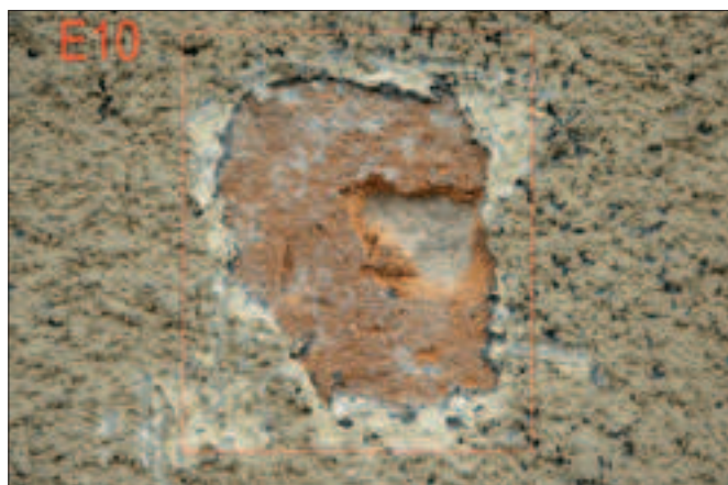
Il. 6. Widok odkrywki E10 na elewacji zabytkowego budynku przy ul. 1 Maja 5 w Olsztynie. Widoczne gładkie oryginalne tynki barwione w masie na kolor pomarańczowy wg NCS-u S 2040-Y30R (fot. E. Doleżyńska-Sewerniak)
