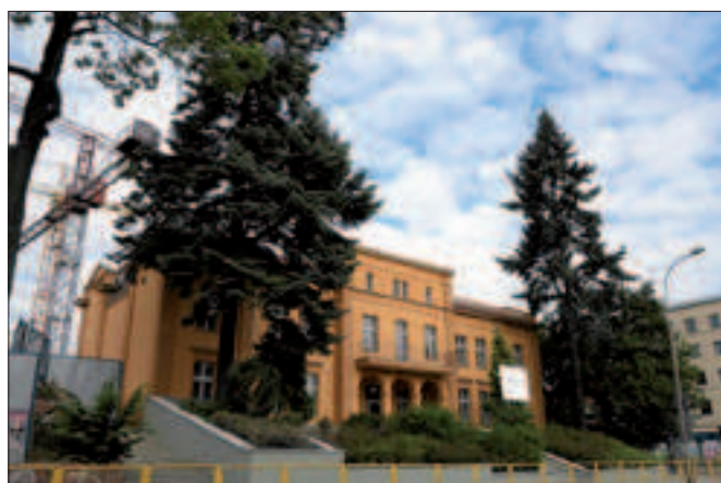
Il. 7. Widok elewacji frontowej zabytkowego budynku przy ul. 1 Maja 5 w Olsztynie po przywróceniu pierwotnej barwy (źródło: Internet)
