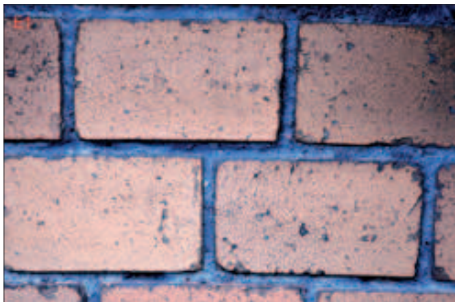
Il. 12. Widok odkrywki E1 na elewacji zabytkowego budynku przy ul. Warszawskiej 53 w Mrągowie. Widoczne barwione w masie na kolor fioletowy spoiny cegieł wg NCS-u między S 4010-R70B a S 5010-R70B (fot. E. Doleżyńska-Sewerniak)
