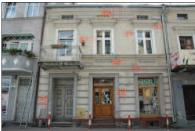
Il. 8. Widok elewacji frontowej zabytkowego budynku przy ul. Żeromskiego 9 w Mrągowie z zaznaczeniem miejsc wykonania badań (fot. E. Doleżyńska-Sewerniak)
