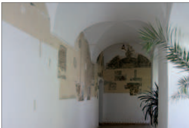
Il. 1. Korytarz na parterze klasztoru poreformackiego w Białej Podlaskiej z odkrywkami dekoracji malarskiej
