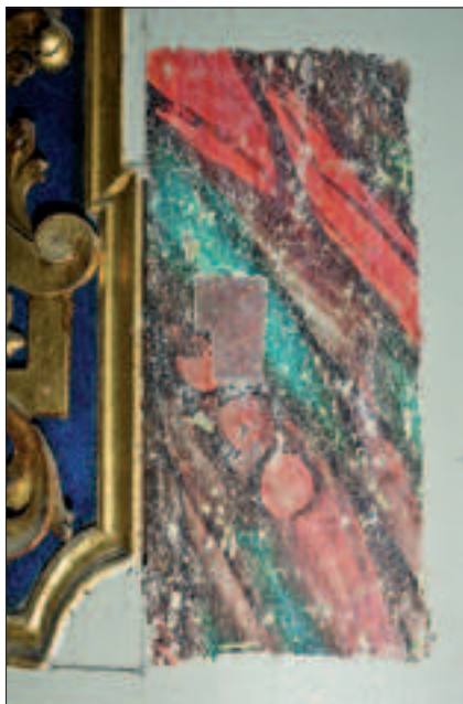
Il. 4. Ołtarz główny, odkrywka na cokole kolumny. Widoczne warstwy pierwotnych barokowych polichromii oraz intensywna w kolorze warstwa z prac prowadzonych w 1928 r. (fot. P. Gorek)
