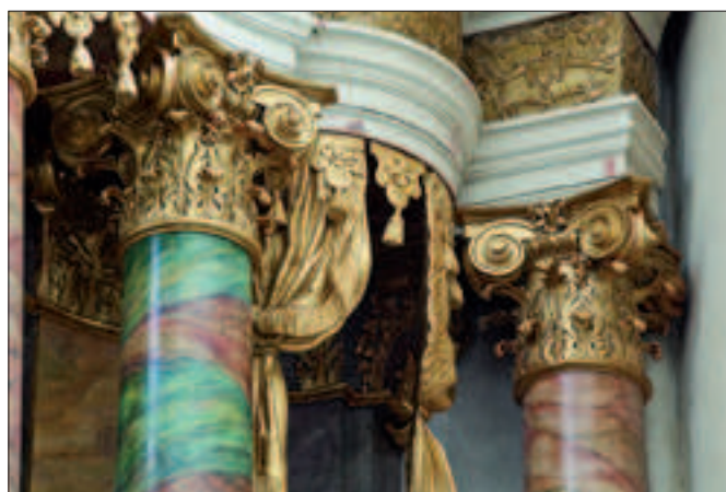
Il. 9. Ołtarz główny, fragmenty kolumn, stan po konserwacji (fot. P. Gorek)
