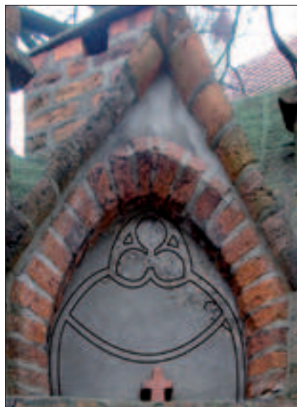
Il. 16. Karner przy kościele św. Jakuba w Toruniu, pierwsza od południowego wschodu blenda z rekonstrukcją rysunku maswerku wykonaną przez M. Kurkowskiego
