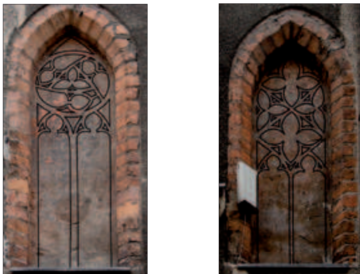
Il. 26. Blendy na elewacji kamienicy przy ul. Szczytnej 21 w Toruniu wraz z propozycją rekonstrukcji rysunku maswerku – M. Kurkowski
