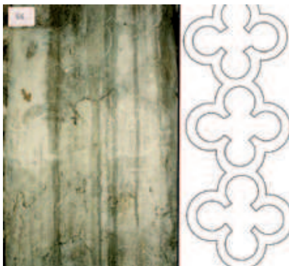
Il. 10. Pole pierwszego od zachodu słupka sterczynowego trzeciego przejazdu wraz z rekonstrukcją maswerku, repr. fot. wg B. Rouba 1996, fot. nr 66, rekonstrukcja M. Kurkowski
