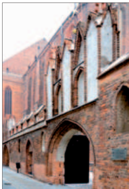
Il. 8. Mur przy kościele Wniebowzięcia NMP w Toruniu (fot. M. Kurkowski)
