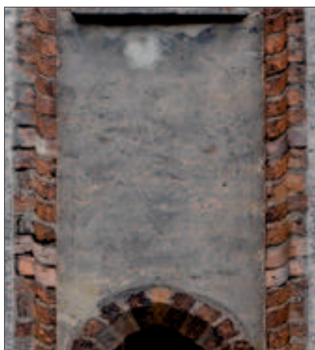
Il. 18. Ryty maswerku w wysokiej blendzie na elewacji przy ul. Szczytnej 2/4 (fot. M. Kurkowski)
