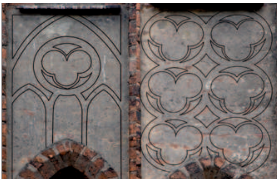
Il. 22. Zachowane ryty i rekonstrukcja rysunku maswerku w wysokiej blendzie na elewacji kamienicy przy ul. Szczytnej 2, 4 rekonstrukcji rysunku maswerku dokonał M. Kurkowski
