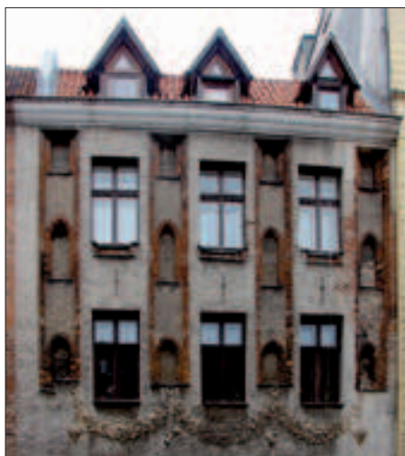
Il. 17. Elewacja kamienicy przy ul. Szczytnej 2/4, stan obecny (fot. M. Kurkowski)
