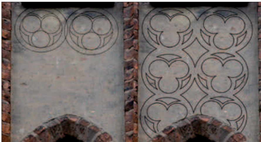
Il. 23. Zachowane rytne i rekonstrukcja rysunku maswerku w wysokiej blendzie na elewacji kamienicy przy ul. Szczytnej 2, 4 rekonstrukcji rysunku maswerku dokonał M. Kurkowski
