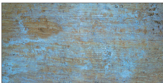
Fot. 5. Fragment płaszczyzny próbki 44 zanurzonej w trakcie impregnacji w roztworze zawierającym eter metylowy glikolu dipropylenowego, po upływie roku od zakończenia zabiegu (fot. K. Szczepińska) Widoczne są rozległe zabielenia.
