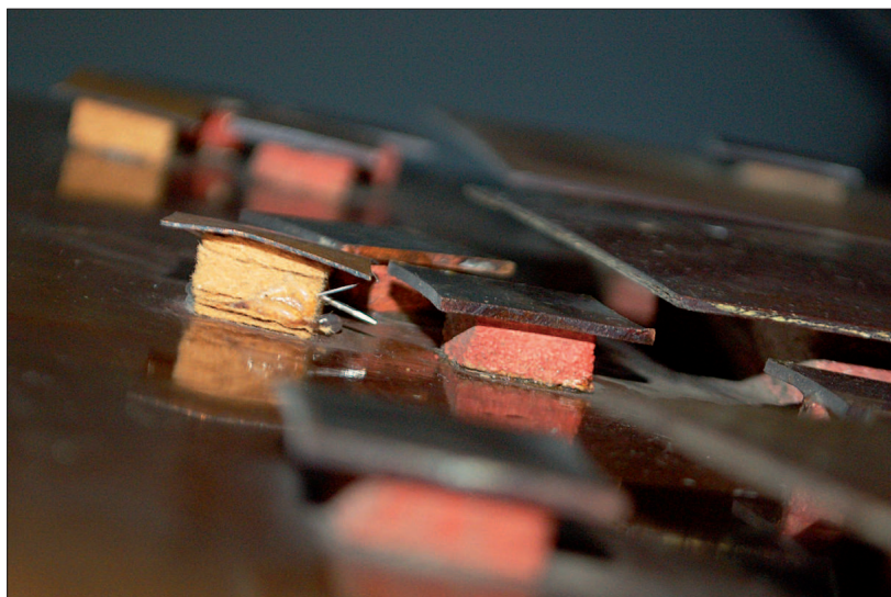
Il. 16. Zbliżenie fragmentu lica, widoczny sposób przymocowania figur geometrycznych
