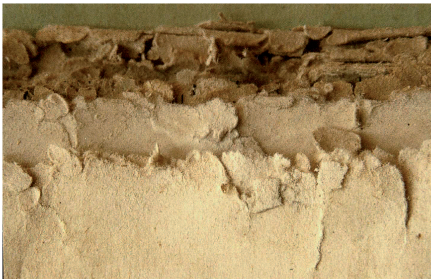
Il. 8. Puszysta destrukcja bloku archiwaliów (fot. K. Zykubek)
