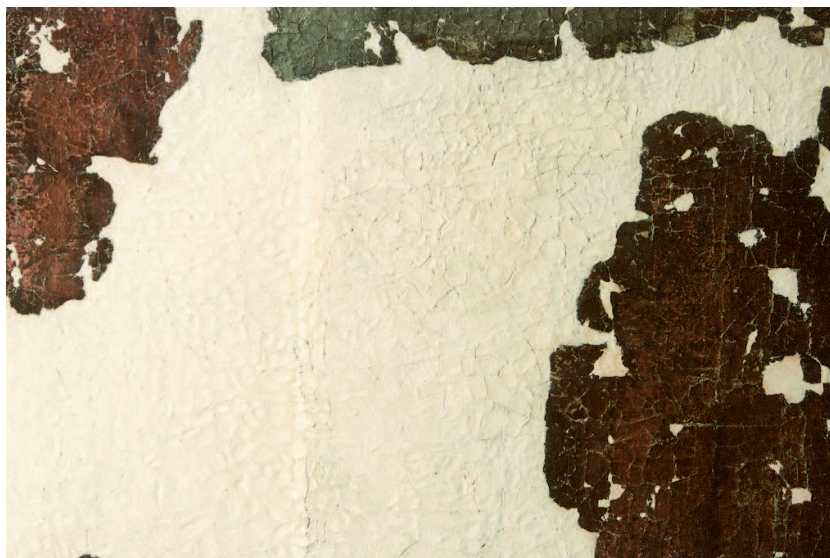
Il. 10. Właściwe opracowanie faktury kitu emulsyjnego, imitujące spękania warstwy malarskiej – uzyskane przez wycinanie i podrzeźbianie w suchym wypełnieniu. Reprodukacja fot. 39 za: E. Kallinen, Dokumentacja prac konserwatorskich i restauratorskich obrazu Matka Boska Różańcowa , nr inw. ZKMiRP 1175, Toruń 2005 (fot. E. Kallinen)
