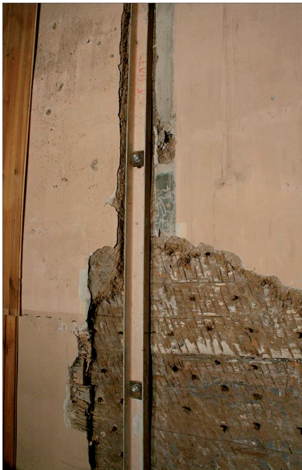
Il. 10. Kościół w Kosieczynie – odkrywka na południowej ścianie nawy – widoczne pierwotne opracowanie barwne ściany: błękit w partii lamperii, biel w części górnej (fot. A. Cupa)
