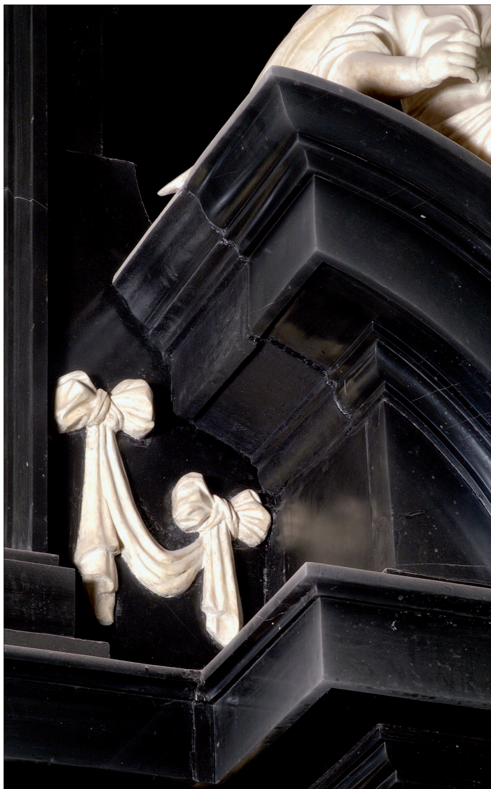
Il. 35. Fragment naczółka ołtarza w kaplicy Kołudzkiej. Widoczna chusta rekonstruowana, wykonana z gipsu (fot. A. Skowroński)
