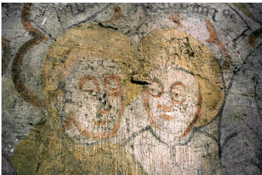
Il. 6. Morąg, kościół św. Apostołów Piotra i Pawła. Prezbiterium, fragment ściany północnej: malowidło Wielka Rodzina Marii (detal), widoczne ślady uszkodzenia mechanicznego przez gwoździe. Fot. J. Małek
