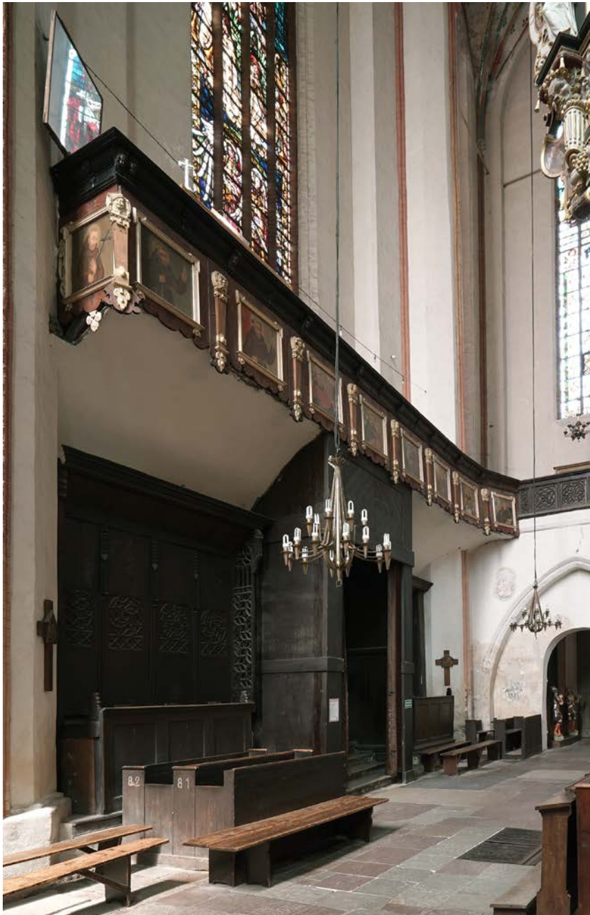
Il. 31. Toruń, kościół WNMP, widok na ścianę zachodnią ze stallami, wiatrolapem przy portalu głównym oraz nadwieszoną emporą zachodnią. Fot. J. Raczkowski
