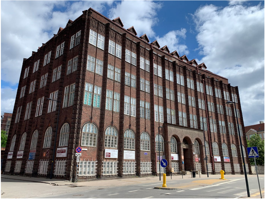
Il. 1. Gdańsk, budynek Powszechnej Rejonowej Kasy Chorych, widok na fasadę. Fot. W. Stasińska
