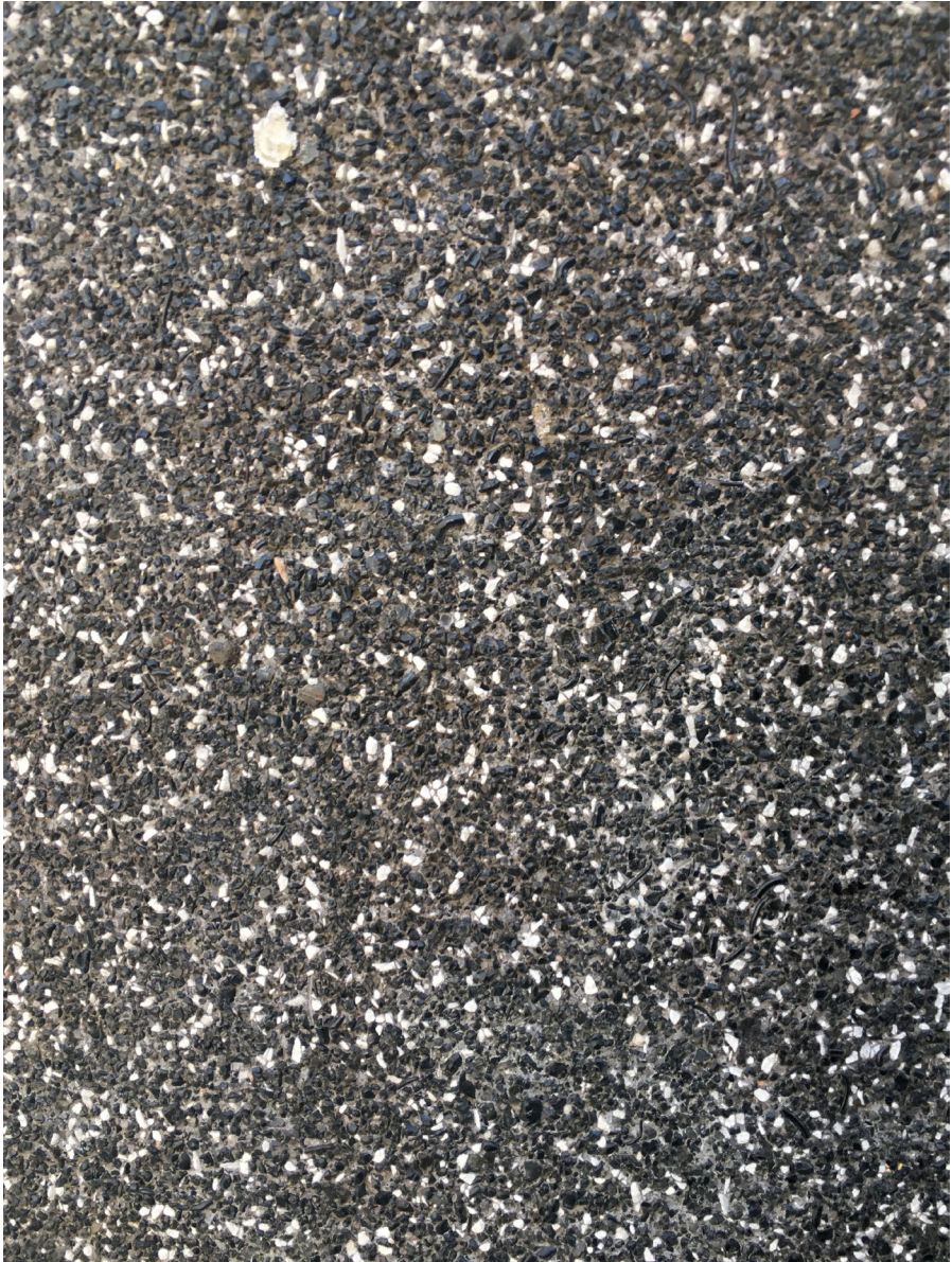
Il. 5. Gdańsk, budynek Związku Gospodarczego Miast Morskich, fragment fasady – tynk zmywany z filarów. Fot. W. Stasińska
