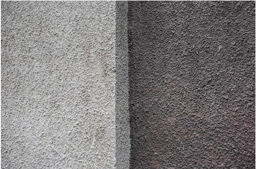
Il. 7. Gdańsk, budynek B Wydziału Chemii Politechniki Gdańskiej, fragment elewacji bocznej – dwa rodzaje tynku nakrapianego (beżowy i ciemnofioletowy). Fot. M. Kortas
