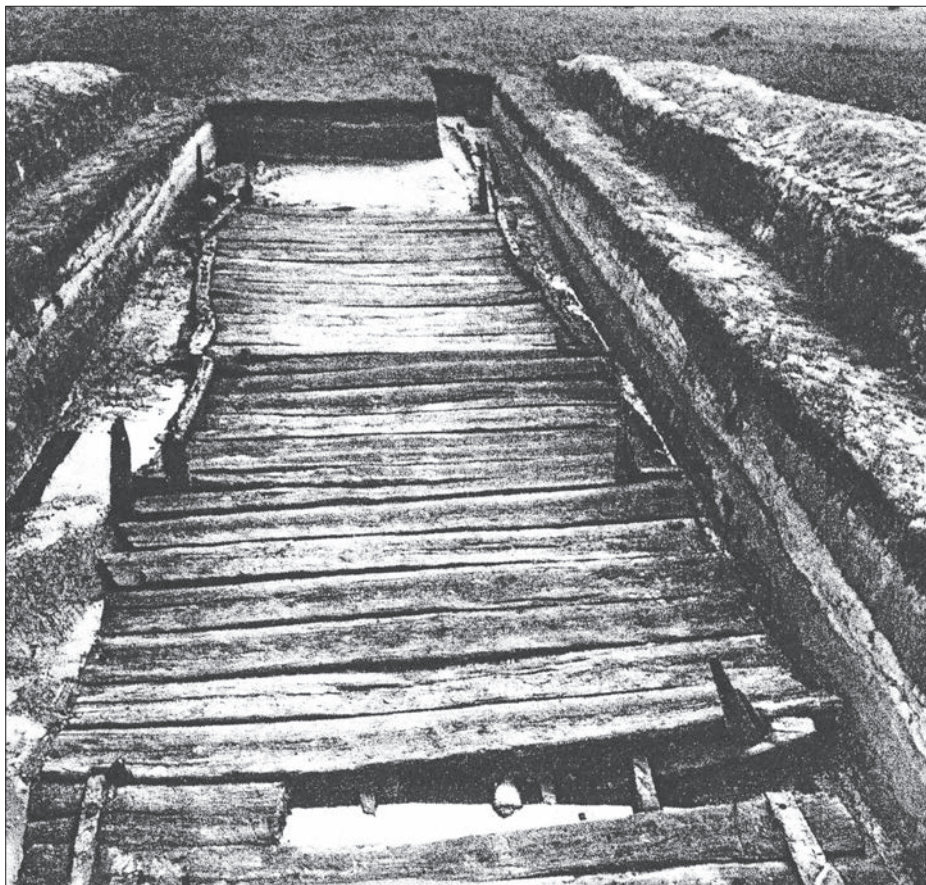
Ryc. 59. Teterow (Mecklenburg-Vorpommern). Dębowe dranice nawierzchni mostowej odkryte na lądowym, początkowym odcinku mostu na długości 15 m (wg Unverzagt, Schuldt 1963, wkładka 1)
