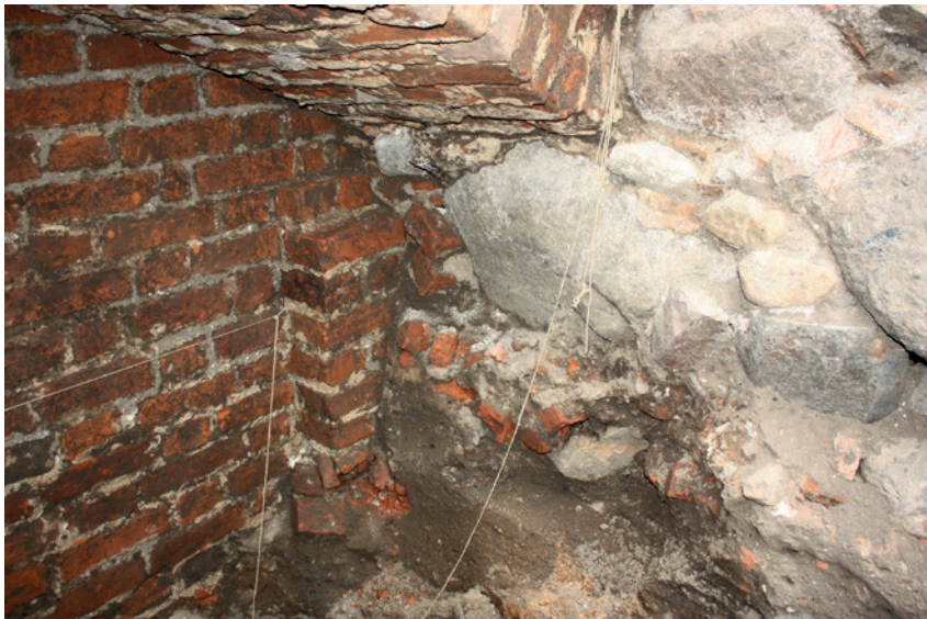
Ryc. 10. Toruń, kościół św. Jakuba. Wykop W-16/15. Widok od dołu na opór arkady i fundament przypory nr 13; po lewej mur za arkadą (fot. J. Struwe)
