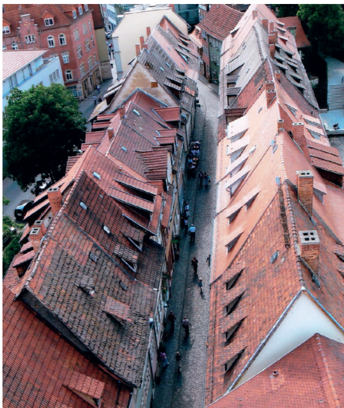
Ryc. 25. Erfurt, Krämerbrücke. Widok ogólny na dachy budynków mostowych z wąską ulicą między nimi (fot. G. Wilke)
