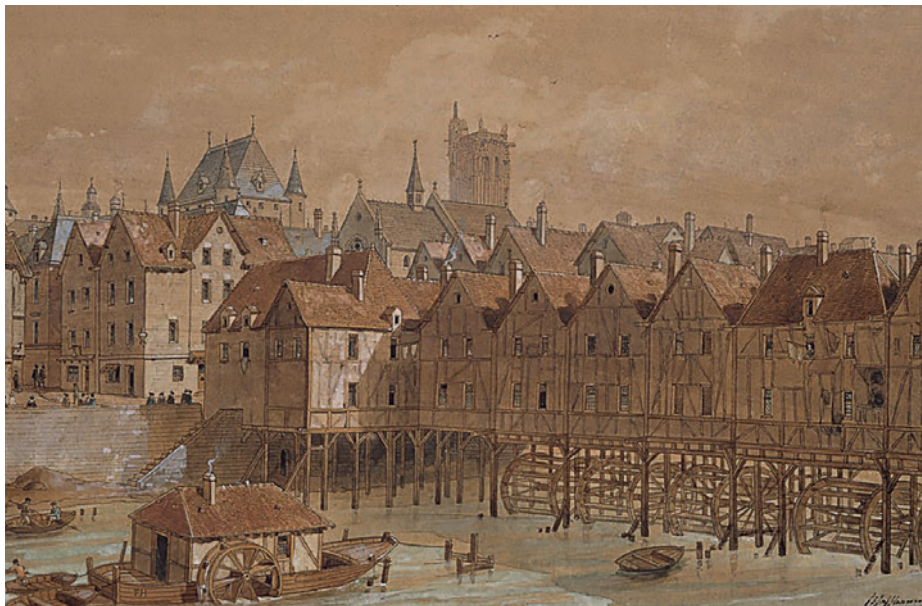
Ryc. 6. Paryż. Widok ogólny na most Pont-aux-Meuniers z dwukondygnacyjną zabudową domów o drewnianej konstrukcji szachulcowej i palowej, jednorzędowej konstrukcji nośnej mostu (fot. Meisterdrucke. Wikimedia-Fotoanzeige)
