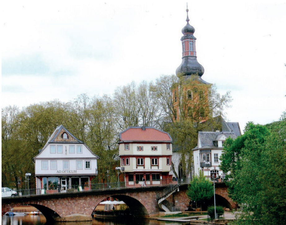
Ryc. 32. Bad Kreuznach, Altebrücke. Widok ogólny domów mostowych od strony ulicy, stojących w części na filarach mostowych (od prawej domy nr 92, 94 i 96) (fot. G. Wilke)
