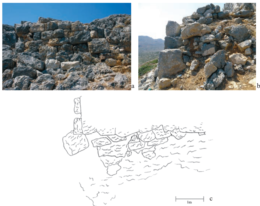
Ryc. 5. Wielka Wieża Wschodnia. Narożnik południowo-wschodni: a – widok ogólny; b – wypełnienie wieży widoczne w środkowej (zawalonej) sekcji południowej; c – rzut (fot. D. Borowka, rys. M. Protonotariou)
