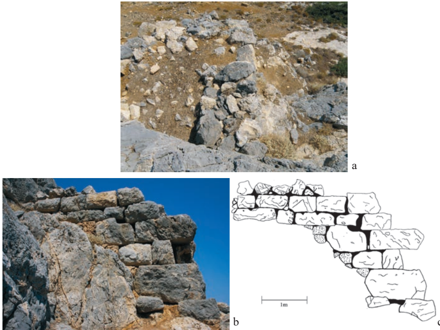
Ryc. 4. Wielka Wieża Wschodnia. Ściana południowa: a – widok z góry; b, c – widok lica południowego. Dwa równoległe rzędy szarych, metamorficznych kamieni ciągną się wzdłuż krawędzi podłoża skalnego, zewnętrzna powierzchnia drugiego rzędu (po lewej stronie) znajduje się około 1,38 m od zewnętrznej krawędzi (fot. D. Borowka, rys. M. Loukopoulou)
