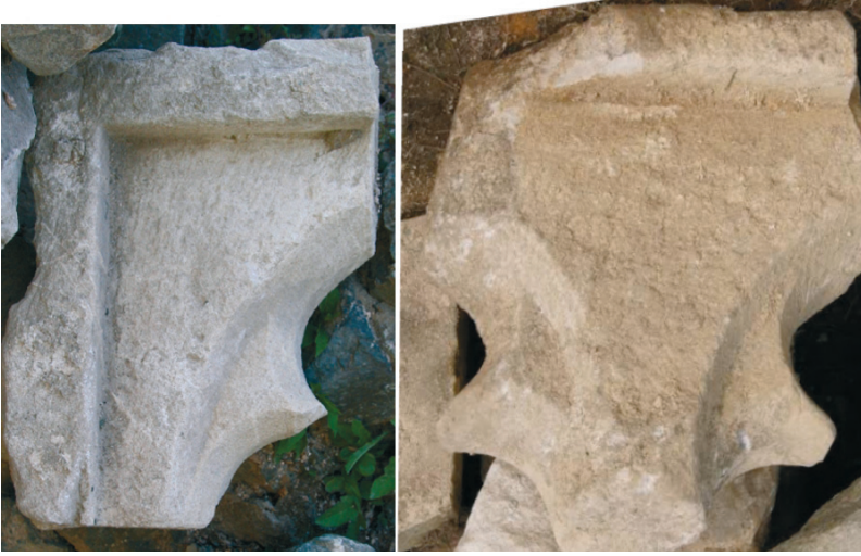
Ryc. 18. Wleń. Relikty obramowań trójlistnych otworów okiennych. Prawy fragment pochodzi z wieloprzezroczowego otworu (biforium, triforium?) (fot. P. Nocuń) Fig. 18. Wleń. Relics of the frames of trefoil window openings. The right fragment comes from a multi-opening (biforium, triforium?) (photo by P. Nocuń)
