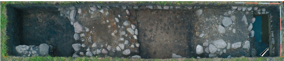
Ryc. 13. Żelechów, pow. Garwolin. Wykop 7. Korony trzech kamiennych fundamentów odsłoniętych pod brukiem z fazy II (fot. W. Bis)
