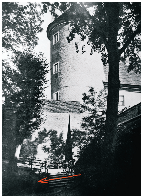
Ryc. 12. Zamek w Pasłęku. Widok od zachodu, od strony promenady otaczającej mury miejskie. Na pierwszym planie ścieżka, pod nią odsłonięty łęk z fundamentu muru (zaznaczony czerwoną strzałką) (wg Helwig 1987)
