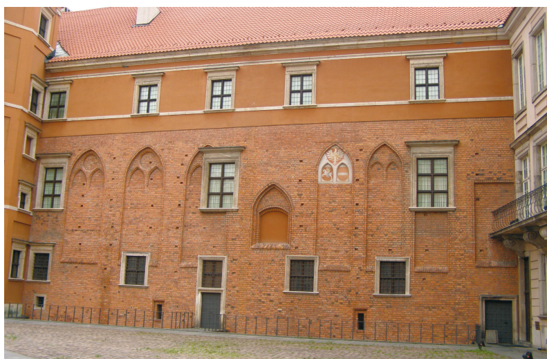
Ryc. 3. Warszawa. Zamek Królewski – tzw. Dwór Wielki; zrekonstruowana fasada (fot. P. Lasek)
