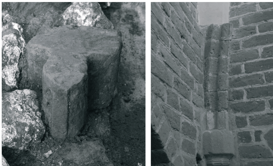
Ryc. 16. Kraków, klasztor Dominikanów. A – wczesnogotycka kształtka o profilu gruszkowatym z 3. ćwierci XIII wieku, stanowiąca element konstrukcyjny żebra sklepiennego, odkryta w kontekście pieca produkcyjnego nr 2 na III wirydarzu; B – wspornik z analogicznym przekrojem żebra sklepiennego zachowany in situ w tzw. Skarbczyku we wschodnim skrzydle klasztoru (fot. D. Niemiec)
